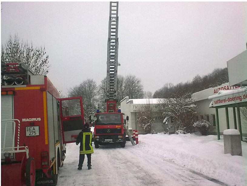
Befreien eines Daches von Schneelasten
